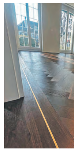
Ein Parkettboden mit speziell eingelegtem Messingfries.
